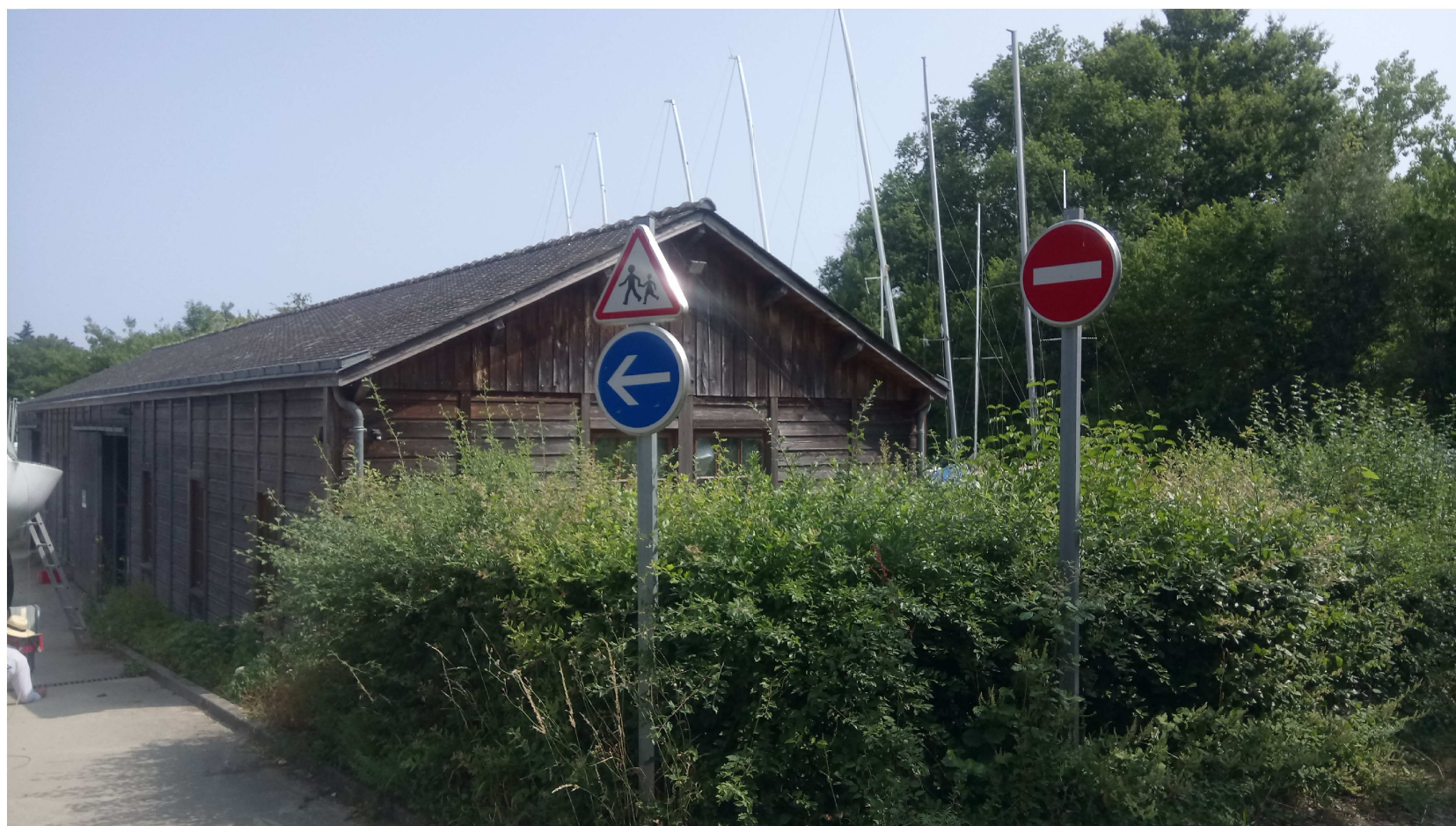
Vue depuis l'arrière des vestiaires- Bâtiment STOCKAGE BATEAUX
