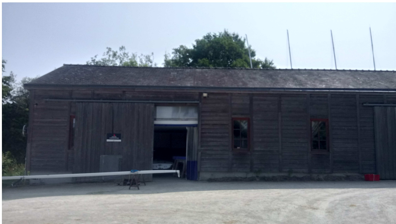
Vue depuis la zone de stockage optimistes sur rateliers- Bâtiment STOCKAGE BATEAUX
