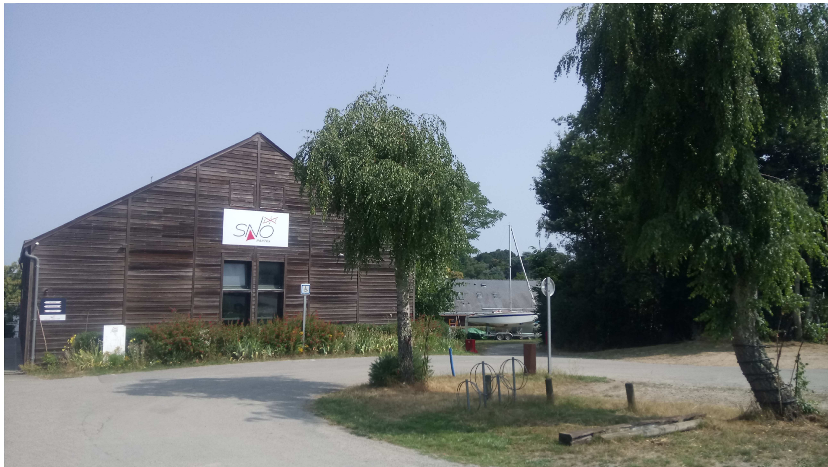
Vue depuis le parking d'entr e- B timent STOCKAGE- ADMINISTRATION et VESTIAIRES- LOCAUX TECHNIQUES
