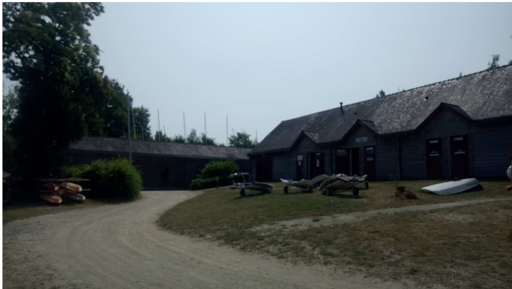
Vue depuis la zone de stockage optimistes sur rateliers- Bâtiment VESTIAIRES ET LOCAUX TECHNIQUES et STOCKAGE BATEAUX
