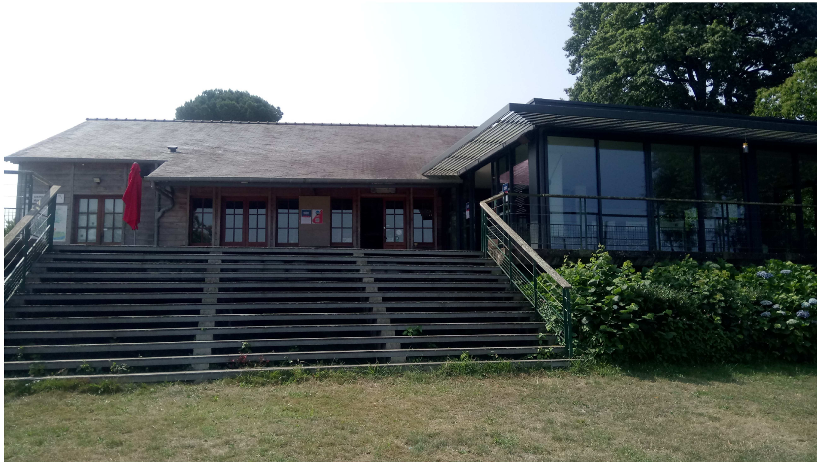
Vue depuis la zone de stockage dériveurs- Bâtiment CLUB HOUSE
